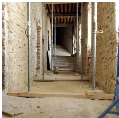
Le pont reliant l'aile Sud à la Tour des Archives en 2009
